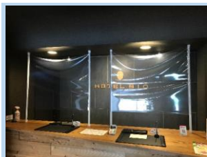
フロント前ビニールシート設置
